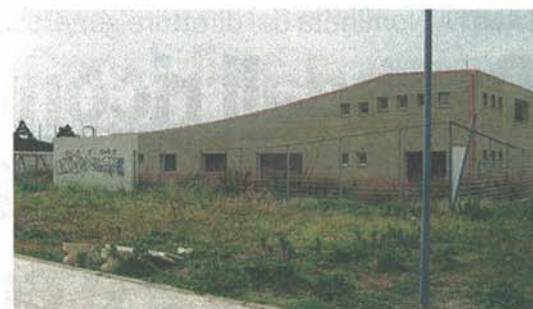
La struttura del Lungomare "visitata" dai vandali
